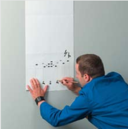
1. Előszerelés a szerelési sablonnal
