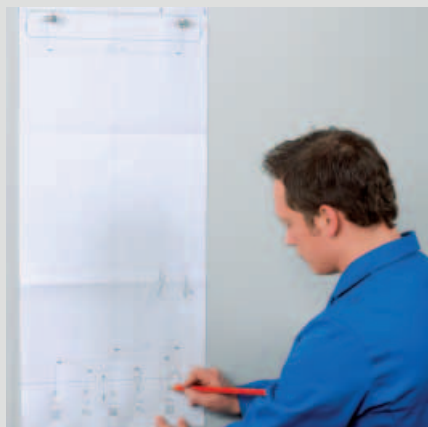
1 Előszerelés a szerelési sablonnal
